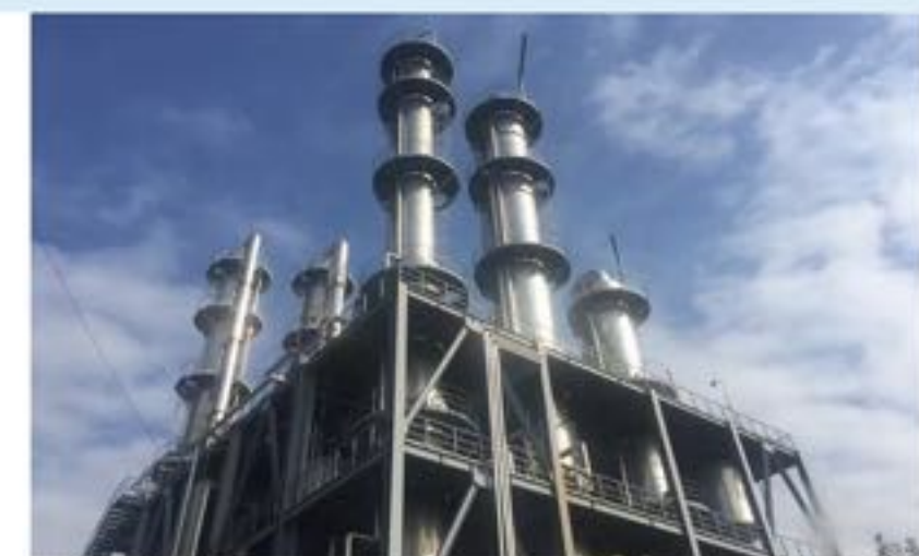
某氨纶企业120t/d-DMAc精制回收项目
